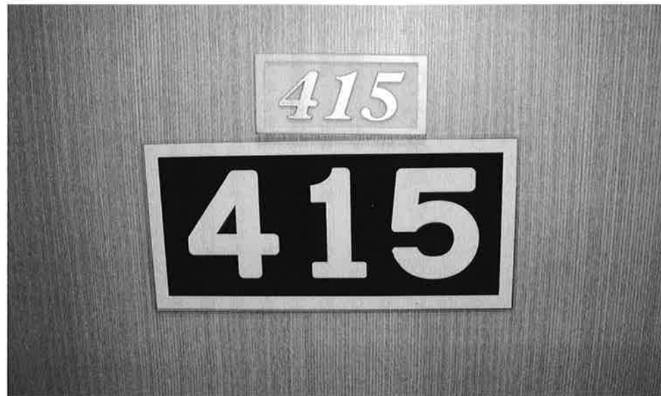
写真② 弱視の方に配慮された、コントラストの強い大きな文字での客室番号表示。手作りのもので、取り外し式となっており、弱視の方が宿泊される場合に使用されている（高山グリーンホテル・岐阜県高山市）
